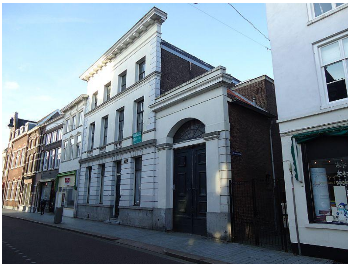
De Roode Kroon is nu een Rijksmonument; het bruine bordje boven naast de voordeur geeft aan dat dit pand de brouwerij was. Het zijstraatje “Achter de Exters” leidde naar het pakhuis Foto Nico Koppers
